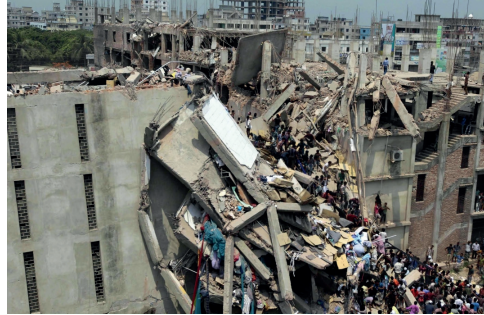
Effondrement d'un immeuble à Dacca, au Bangladesh, le 24 avril 2013 A.M. Ahad/AP/SIPA
