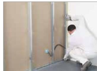
Commencez la seconde face de la cloison par une demi-plaque afin d'éviter des joints en vis-à-vis des deux côtés de la cloison.
